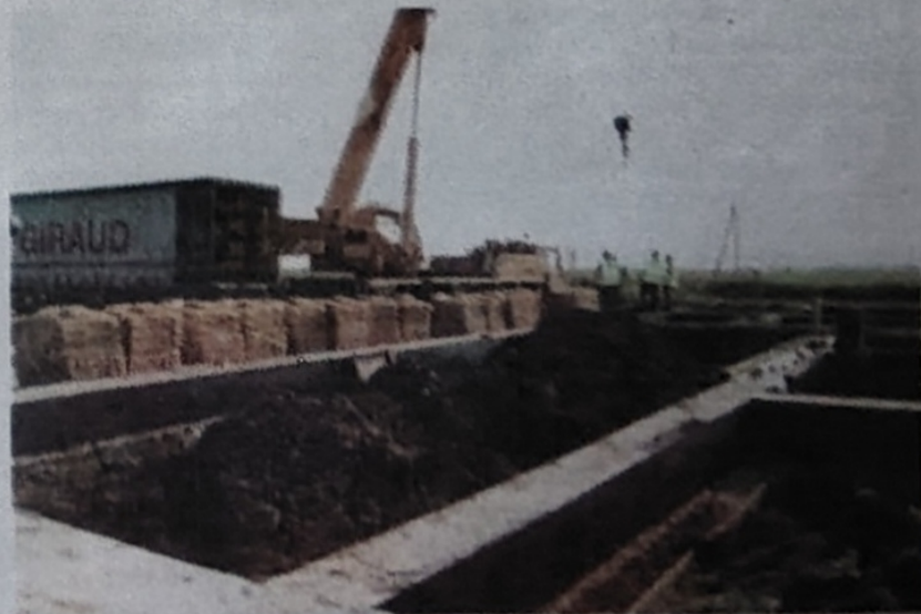
Строительство детского сада
